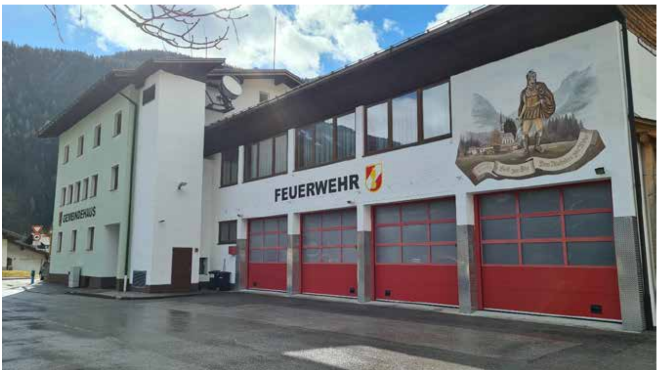
Das Gemeindehaus vor dem Beginn der Umbauarbeiten.
