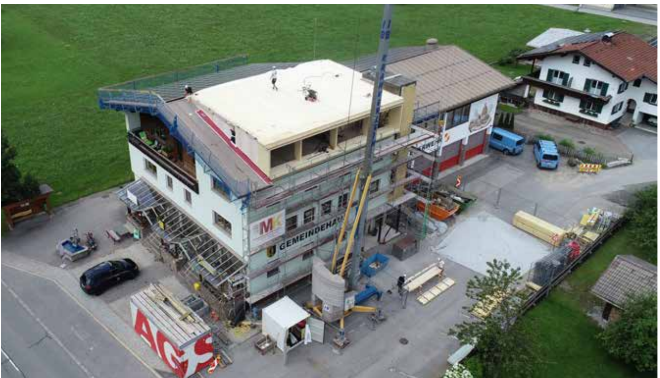
Fertigstellung Dachausbau und Liftschacht im August 2024
