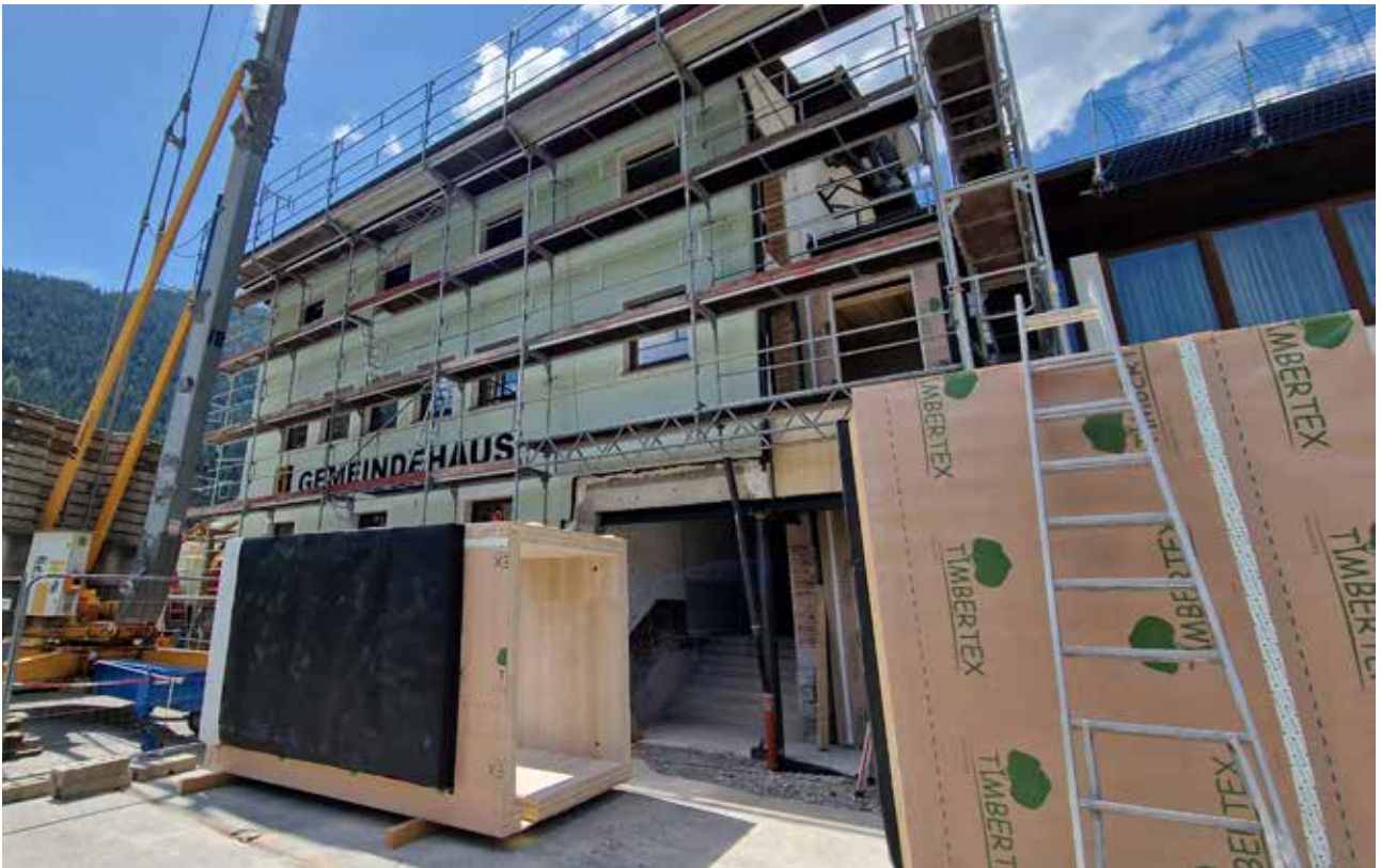
Zubau des Personenliftschachtes und Aufstockung Dachgeschoß in Holzbauweise
